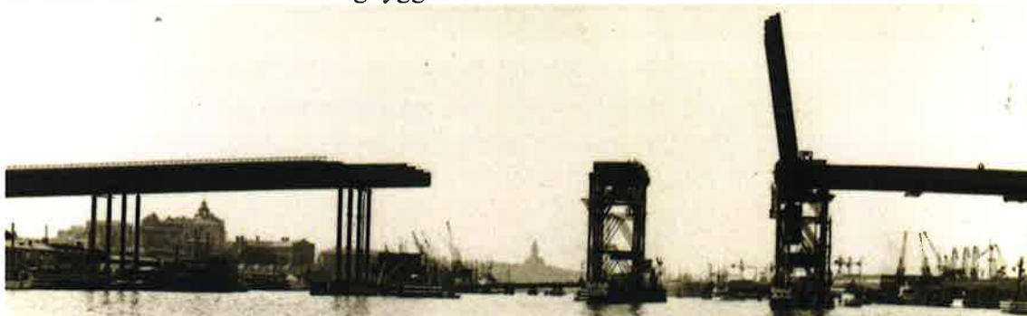
Figur 6: Bilden visar Götaälvbron under byggtiden.
