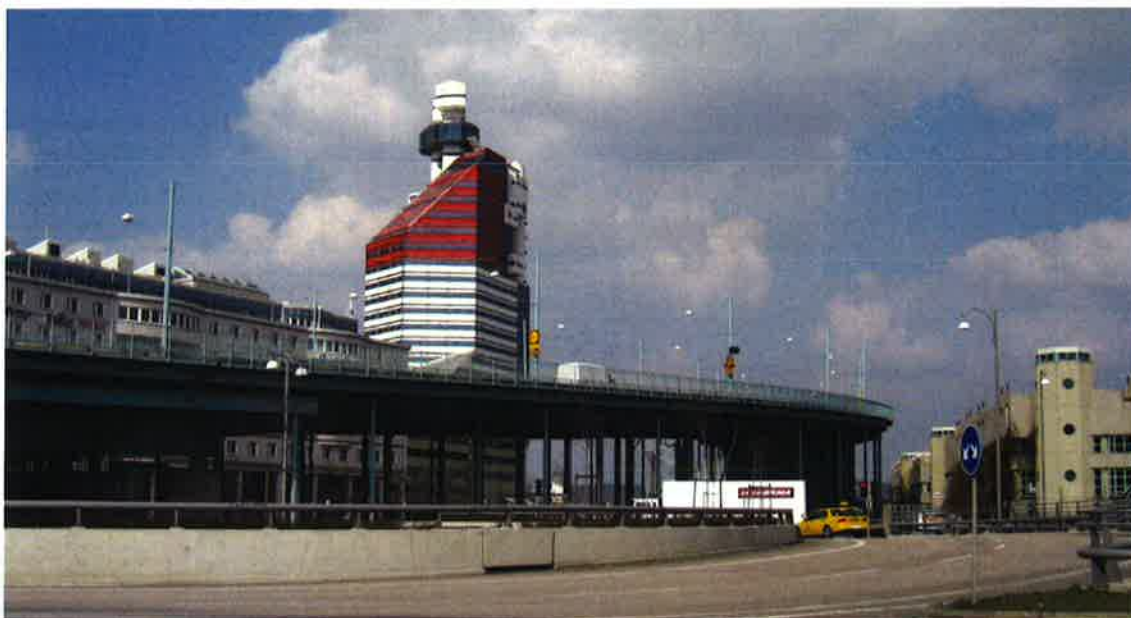
Figur 8: Befintlig bro med Erskines "Läppstiftet" bakom. Till höger i bilden syns befintliga parkeringshus.
